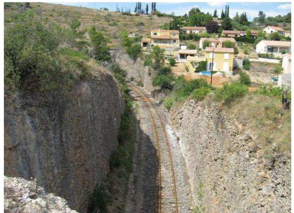
Ces situations sont aussi fréquentes sur les lignes de l'Hérault. Elles ne présentent que peu de risques de mise à feu sauf si la végétation retombe sur la voie. Un traitement est à prévoir au dessus ou derrière l'ouvrage.
